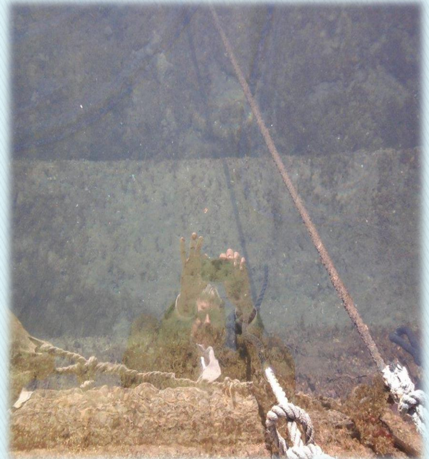
Vue du fond par transparence - Après traitement Talon béton découvert et câbles visibles sur le fond
